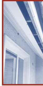
Saillies de toit fermées, orifices de ventilation sans grillage de 3 millimètres (1 point)
